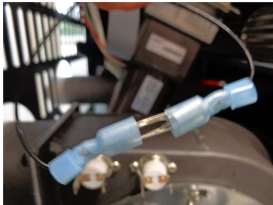
Quand ces deux cosses sont en contact le moteur d'extracteur et le moteur d'air chaud doivent se mettre en marche. S'ils ne se mettent pas en marche, c'est que le problème ne se situe pas au niveau de la sonde mais qu'il s'agit d'un défaut au niveau des connexions : cosses mal serties, fils coupés, voir également le document technique n° 8 qui traite des connexions dans le boîtier de puissance.
